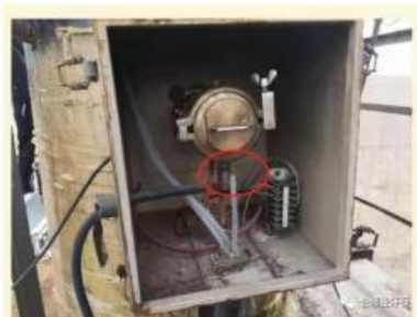
采样探头过滤器，探针管路堵塞
